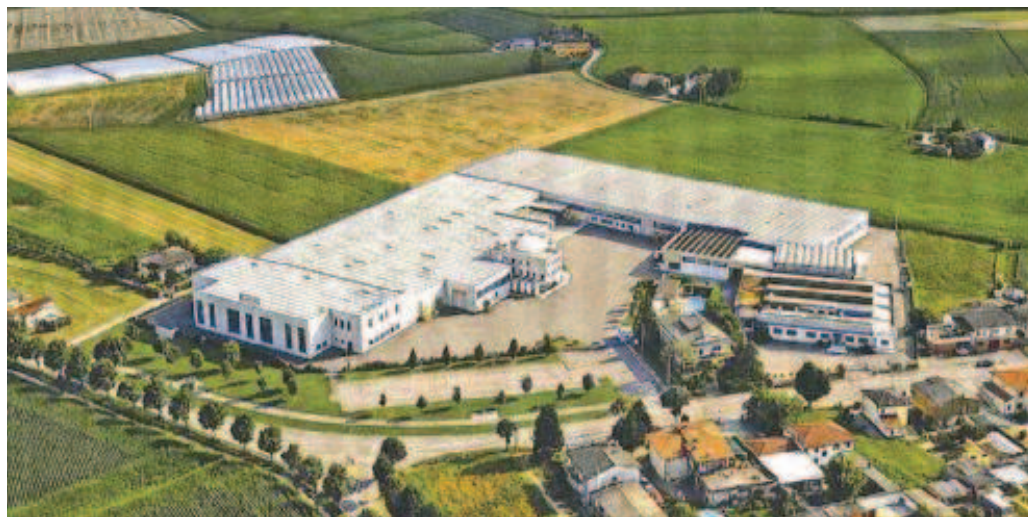
Veduta aerea della Samo leader in Italia nella progettazione e produzione di accessori per il bagno
