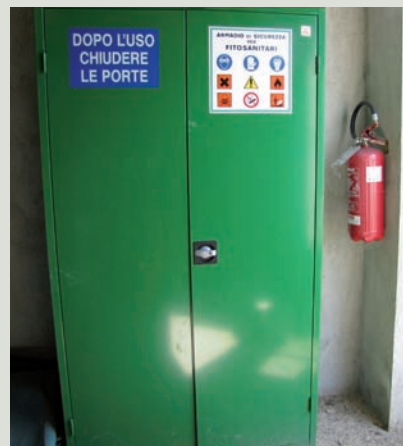
Anche in azienda deve essere presente un armadio specifico per i PF dotato di chiusura di sicurezza
