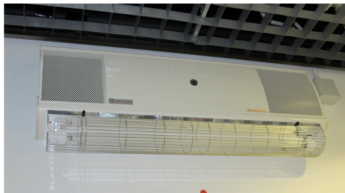
Figura 2 - Esempio di lampada germicida a parete
